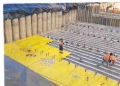
**5.100 LAUFMETER** Ortbetonpfähle für die fertige Bohrträgerwand.
